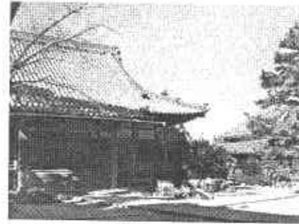
写真3 東南海地震後の康順寺本堂(写真左端と中央の灯籠のみが倒れている).
