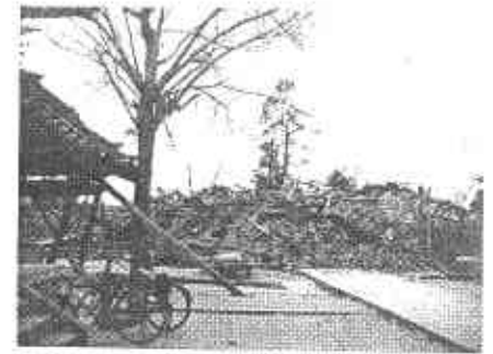
写真4 三河地震後の康順寺本堂(写真中央と右端が写真3と同じ灯籠).
