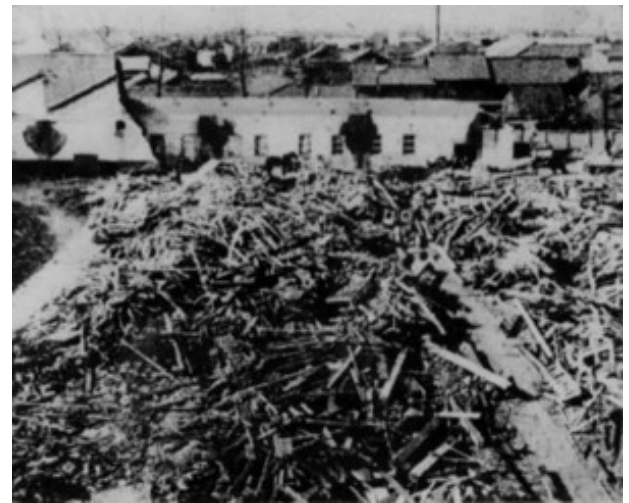
昭和東南海地震で倒壊し、がれきの山となった三菱重工道徳工場
